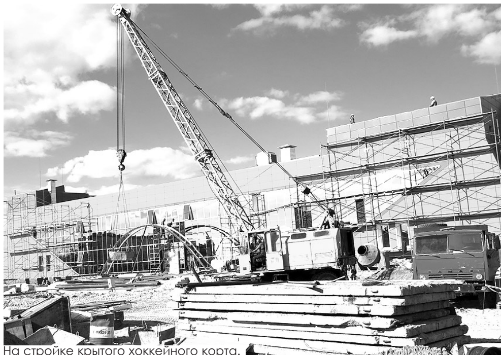
На стройке крытого хоккейного корта.
