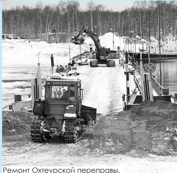
Ремонт Охтеурской переправы.
