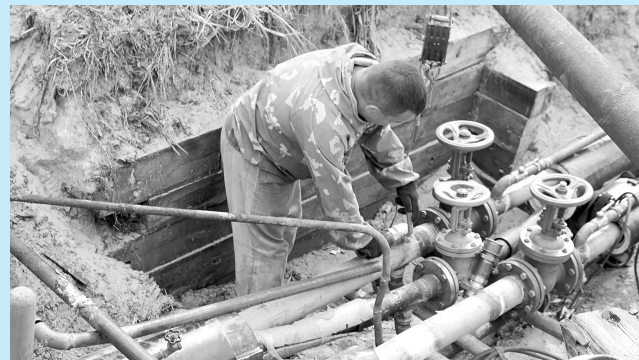
Ремонтные работы на теплотрассе в Варьёгане.
